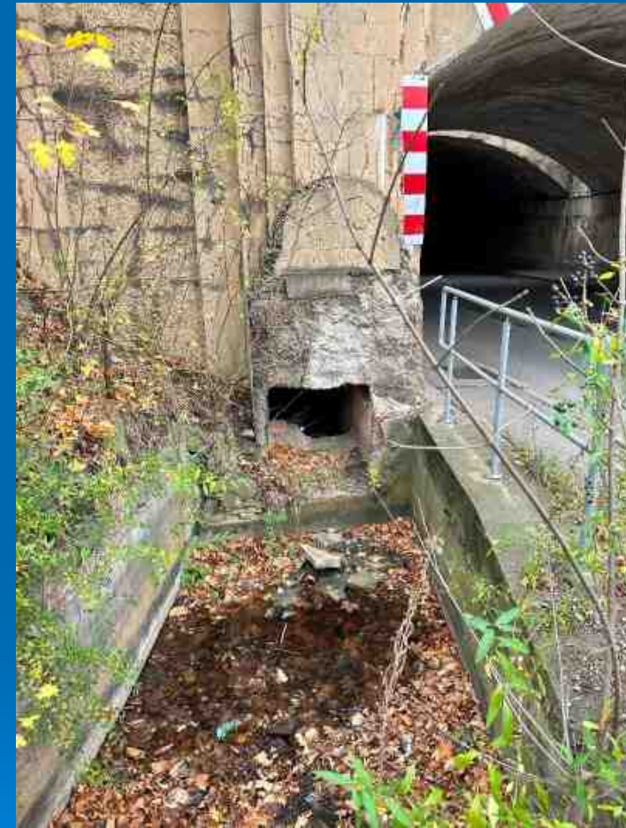
Bahnbrücke Zangenberg wird abgerissen, Verlauf des Floßgrabens in Richtung Zangenberger Teiche wird neu trassiert
